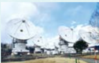
直径10mあるアンテナ6基を合わせた「ミリ波干渉計」。
